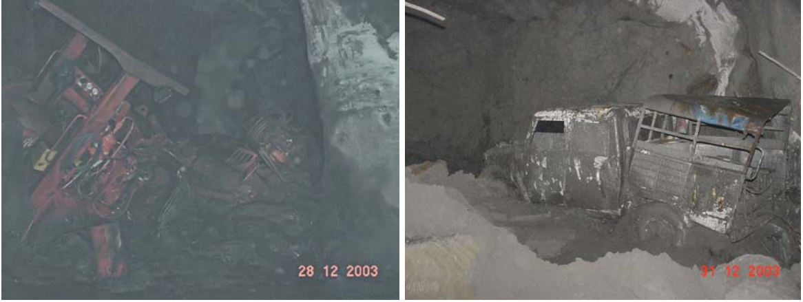
Şekil 31. ÇBİ yeraltı işletmesinde oluşan barikat yıkılmaları ve olumsuz etkileri (Yumlu ve Güreşçi, 2007)
