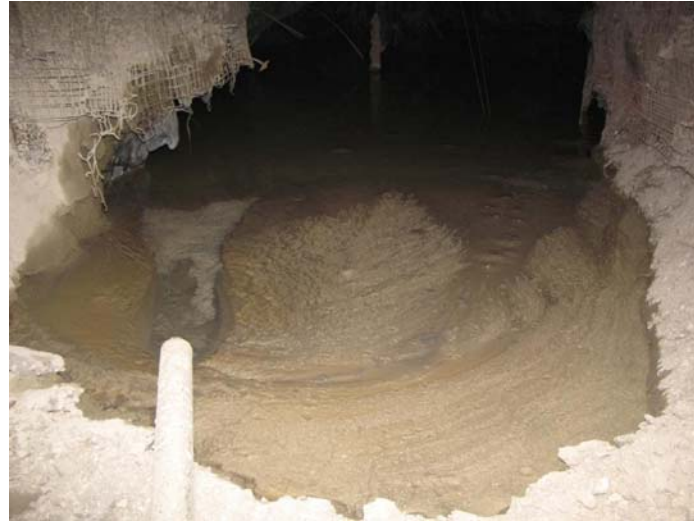
Şekil 29. Macun dolgunun boru hattı ile yeraltına nakliyesi
