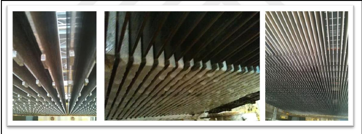
Şekil 8. Lamaların ve elmas soketlerin görünümü (URL-4, 2018).
