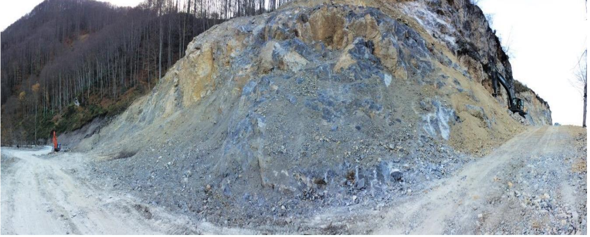
Şekil 2.3. Çalışma sahasındaki Berdiga Formasyonu'na ait kireçtaşlarının görünümü
