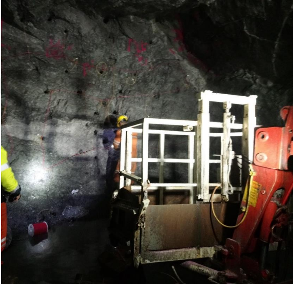
Şekil 14. Deliklerin patlayıcı ile şarjlanması ve yüzey bağlantılarının sağlanması
