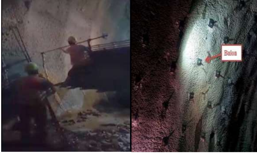
Şekil 1.7. Kaya bulonu uygulaması ve sonrası tünel yüzeyinin görünümü
