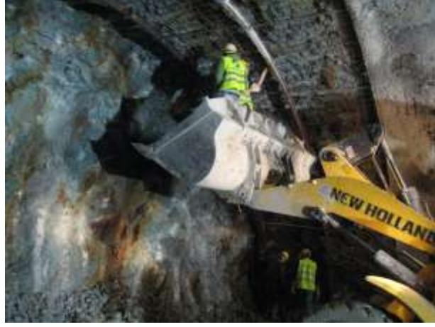
Şekil 1.6. Tünel içinde tahkimat amaçlı olarak kullanılan çelik hasır
