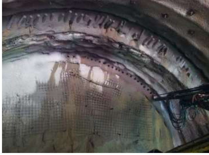
Şekil 1.9. Ön süren uygulaması
