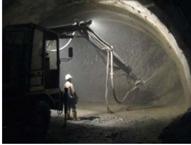
Şekil 1.5. Tünelde püskürtme beton uygulaması
