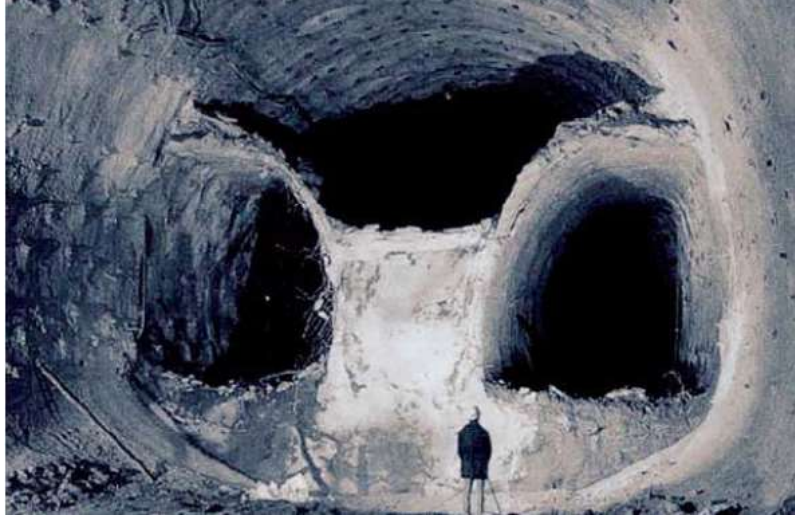
Şekil 1.4. Yumuşak formasyonlarda aşamalı tünel kazısı (Lunardi, 2008).
