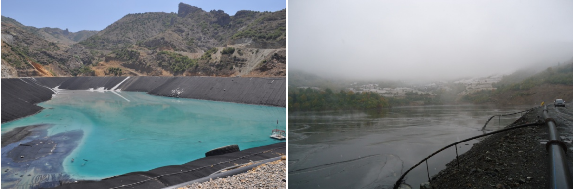
Şekil 6. Cevher zenginleştirme işlemleri sonucu açığa çıkan atıkların atık barajına depolanması
