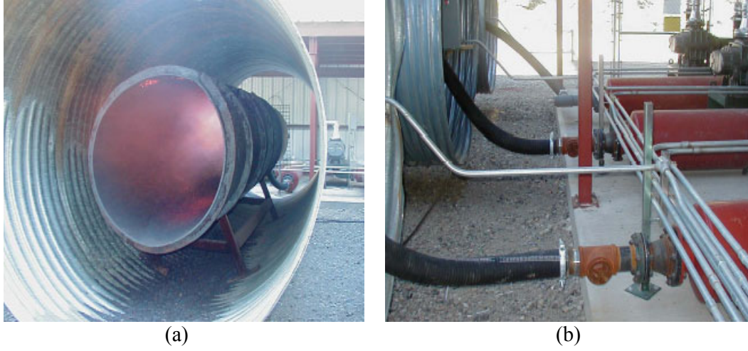
Şekil 2.8. a) Bir maden havası ısıtıcısı, b) gerekli bağlantılar (Jacobson, 2001)
