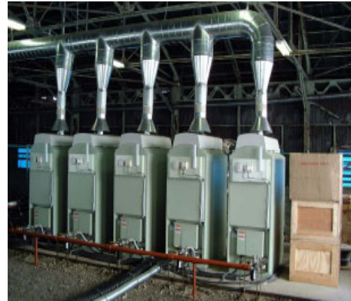
Şekil 2.9. Japonyada Akbira madeninden elde edilen metanın türbinlerde elektrik üretiminde kullanılması (EPA-4, 1998).
