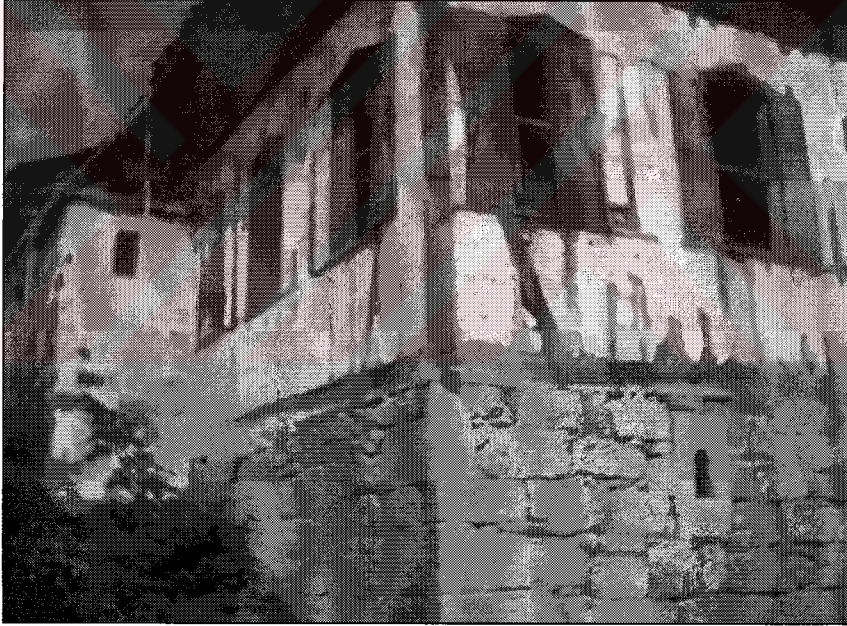
Şekil 16. Ocak çevresinde bulunan yığma temelli, ahşap ev [18].
