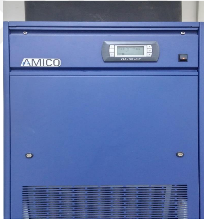
Şekil 10. İklimlendirme odasındaki sıcaklık ve bağıl nemi ayarlayan klima sistemi
