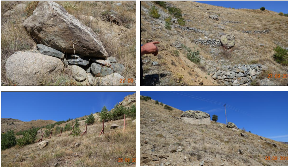
Şekil 11. Tehlikeli bloklar için alınan yerel önlemler (sırasıyla; topuk tamponu, yığma taş, tel ağ ve beton tampon)
