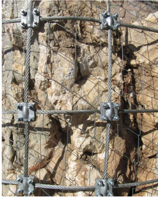
Şekil 52. Çelik halat kesişme yerlerini sabitleme aparatı (Cross Clamp)
