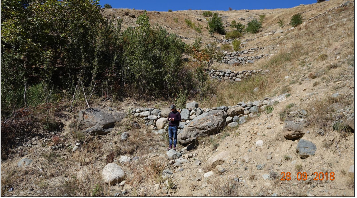
Şekil 17. Proje sahasında 1. Bölgede bulunan oyuntular, oyuntularda görülen birkaç tonluk bloklar ve köylüler tarafından kaya düşmesi risklerini azaltmak için yapılan taş yığma yapılar
