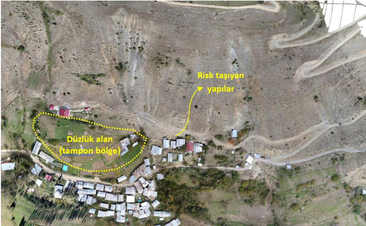
Şekil 16. Proje sahasında 1. Bölgede yoğun yapılaşmanın önünde bulunan ve kaya düşme riskinin azaltan tampon bölge ile doğu kesimde riskli bölgede bulunan yapılar
