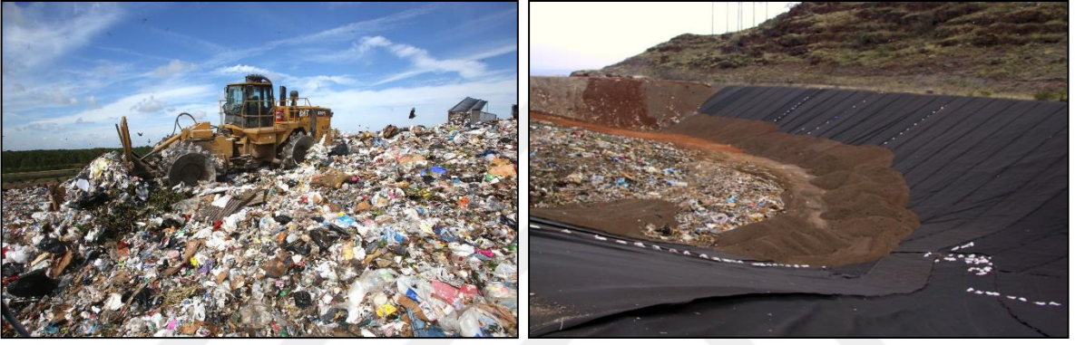
Şekil 1. Atıkların depolama alanlarındaki görünümü (sol fotoğraf: vahşi depolama sahası ve çelik tekerlekli kompaktör, sağ fotoğraf: düzenli depolama alanında taban membranı ve örtü malzemesi)
