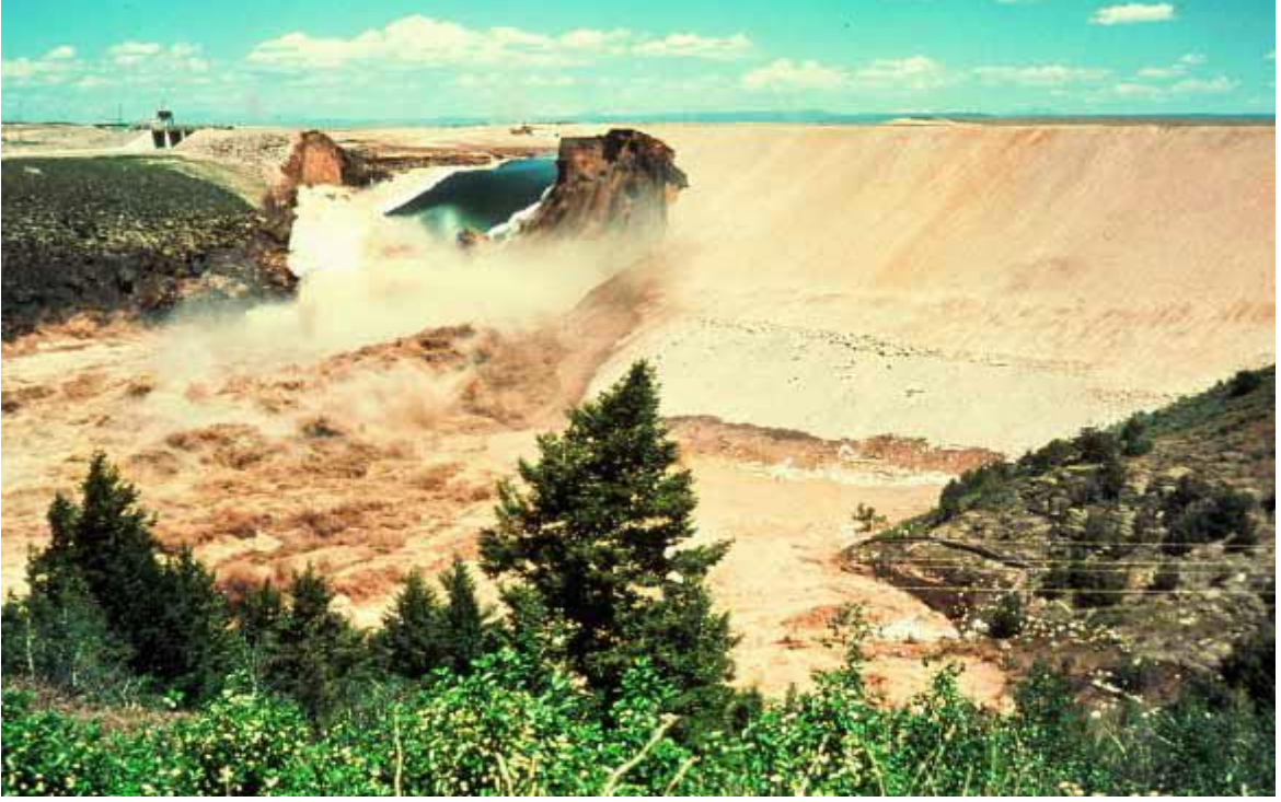
Şekil 1.6. Teton Barajı'nın yıkılışı
