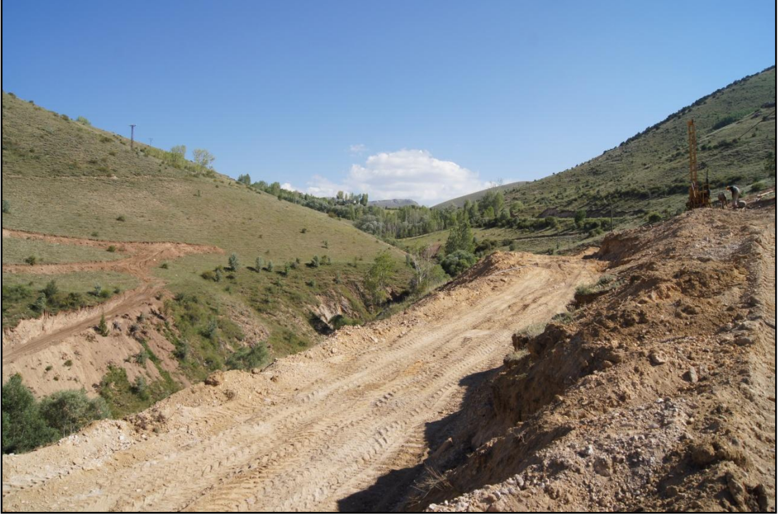
Şekil 3.8. Temel araştırma sondaj çalışmalarından görünüm (Sol sahilden membaya bakış)
