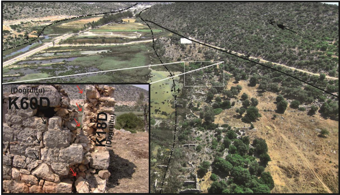
Şekil 39. Andriake limanının yapılarından olan kiliseye ait duvarlardaki sistematik çatlaklar ve GD yönünde eğimlenme (Kırmızı oklar duvarın eğimlenme yönünü, siyah oklar ise taş duvardaki çatlakları göstermektedir). Bakış yönü KD'dur.
