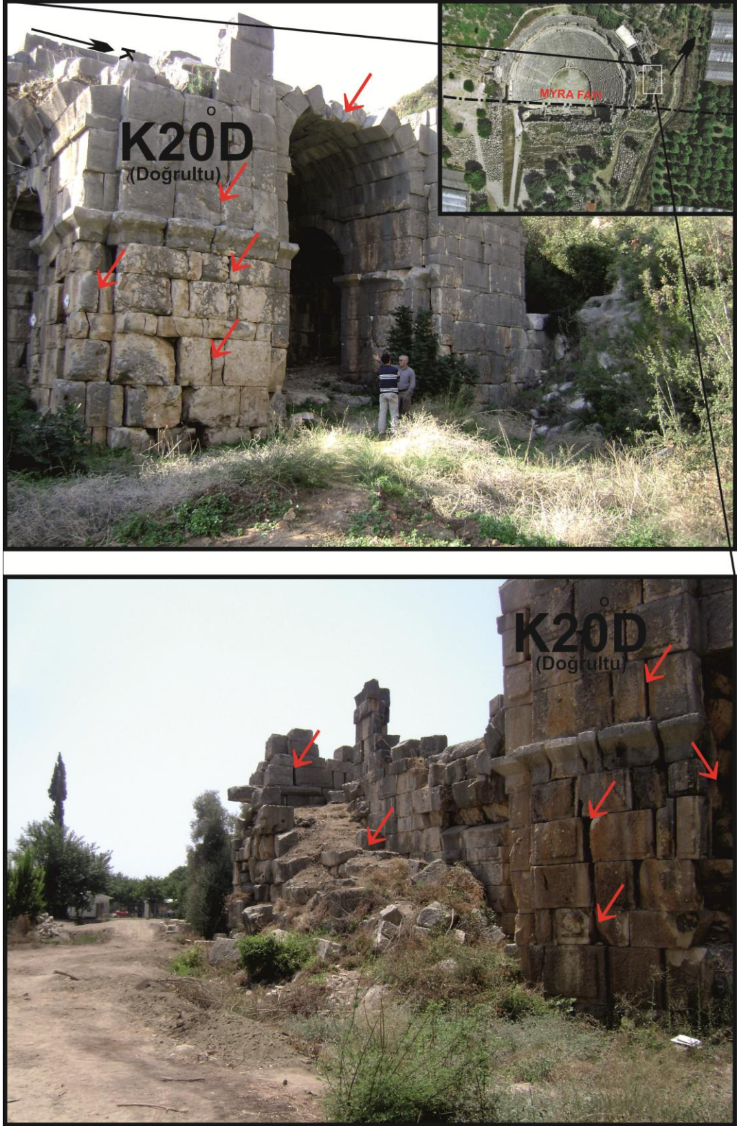
Şekil 35. Tiyatro giriş duvarlarındaki yıkılmalar ve sistematik çatlaklar (Kırmızı renkli oklar taş duvarlardaki ayrılmaları, yıkılmaları, çatlamları göstermektedir). Bakış yönü sırasıyla KB ve GB'dır.
