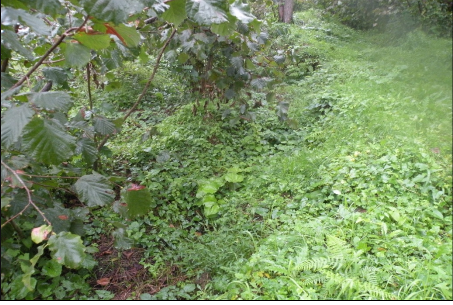
Şekil 60. Heyelanlı alanda oluşmuş gerilme çatlığı
