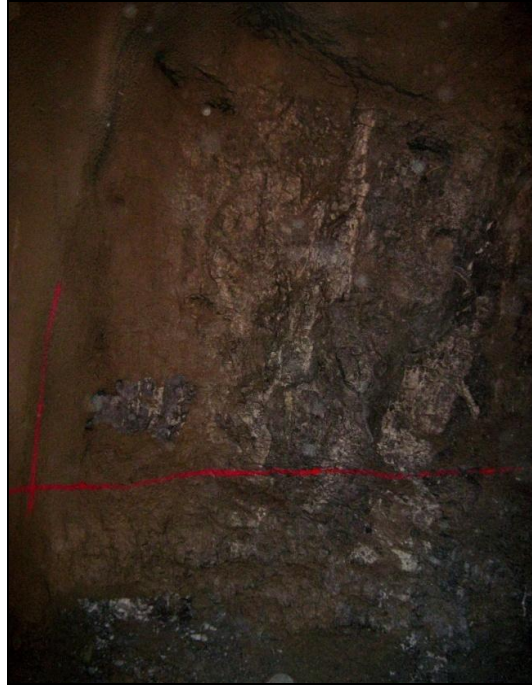
Şekil 3.22. B1340G numaralı üretim galerisinin 86. metresindeki aynanın görünümü.
