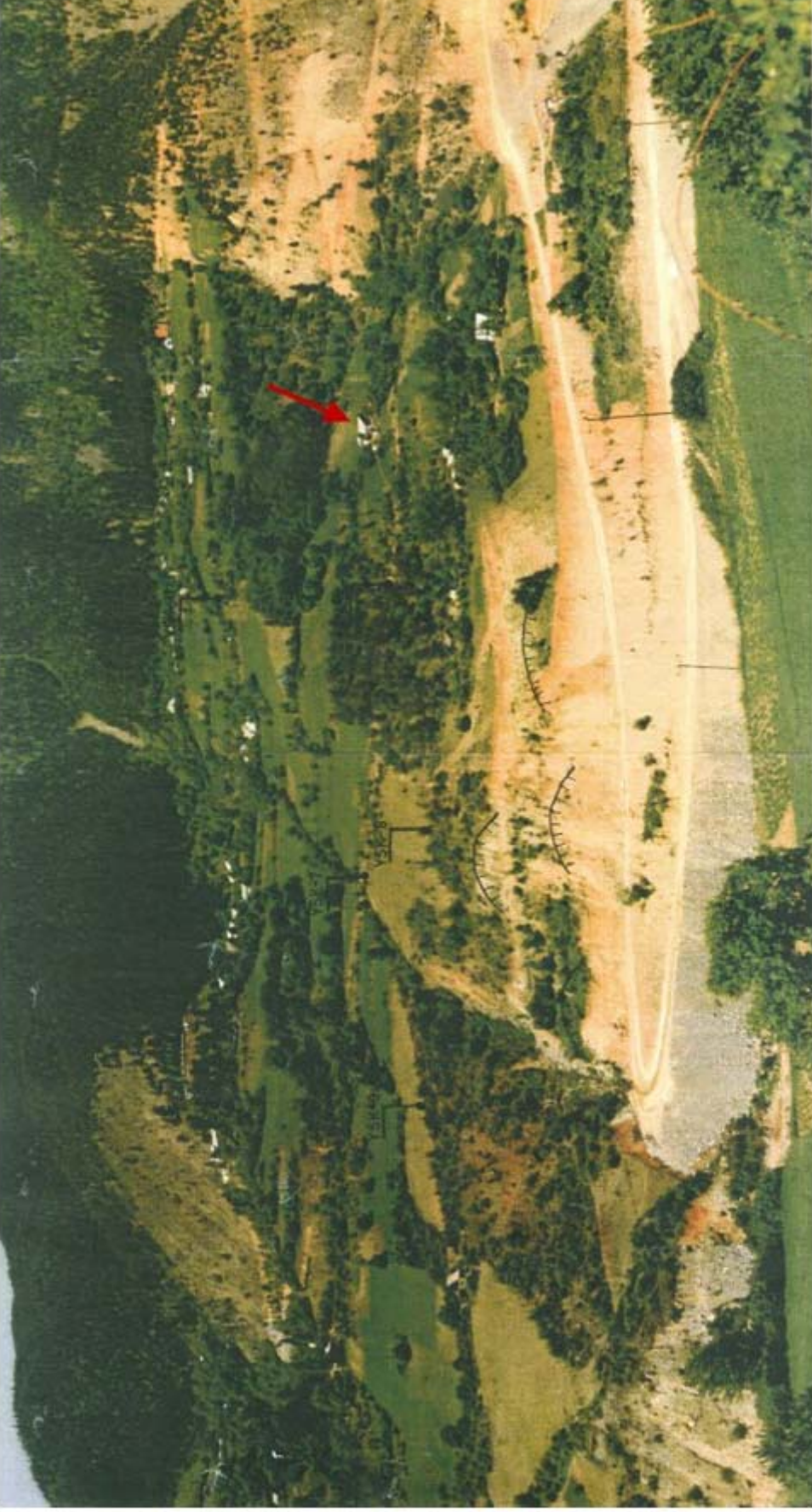
Şekil 59. Torul Barajı sol sahilinin su tutmadan önceki hali
