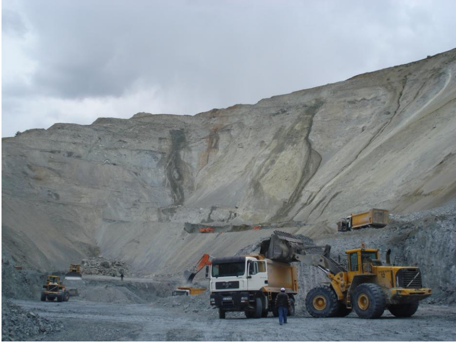
Şekil 3.21. Dünit içerisinde açık işletme yapılan kromit yatağı (Merkez ocak)
