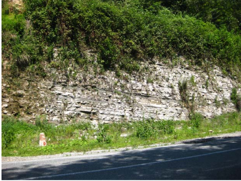
Şekil 14. Kireçhane Formasyonundan genel bir görünüm
