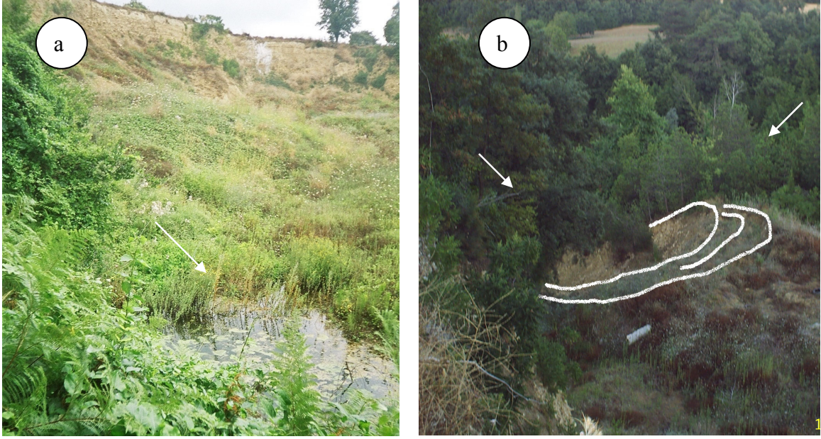
Şekil 20. a) Uçuk Heyelanı ve alt kısmında oluşan su birikintisi, b) Uçuk Heyelanının altında oluşan tali kayma yüzeyi ve çevresindeki ağaçlardaki eğilmeler.
