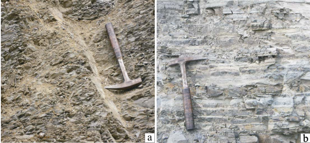
Şekil 3.5. a) Erenköy civarındaki Küre Formasyonu içerisindeki marnlar b) Murgul-Borçka yol yarmasında Balıklıdağ Formasyonunun tabanında izlenen killi kireçtaşı-marn seviyelerinin görünümü
