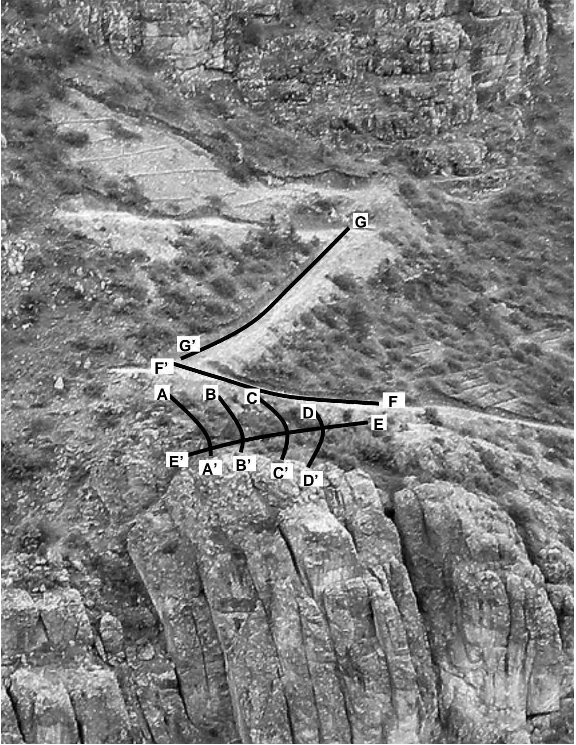
Şekil 109. İnceleme alanında heyelan oluşan yamacın görünümü ve yer radarı ölçü doğrultuları [49]
