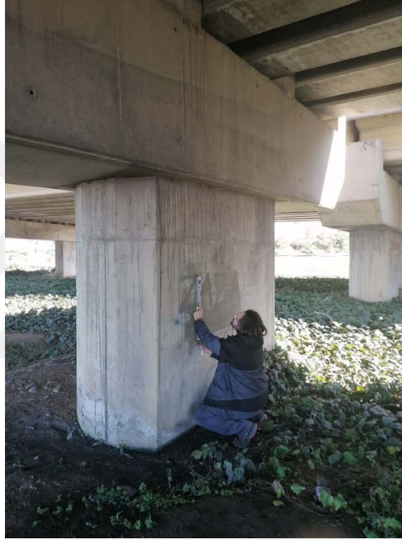
Şekil 52. Viyadük ayağı üzerinde ölçüm profilleri ve noktalarının belirlenmesi
