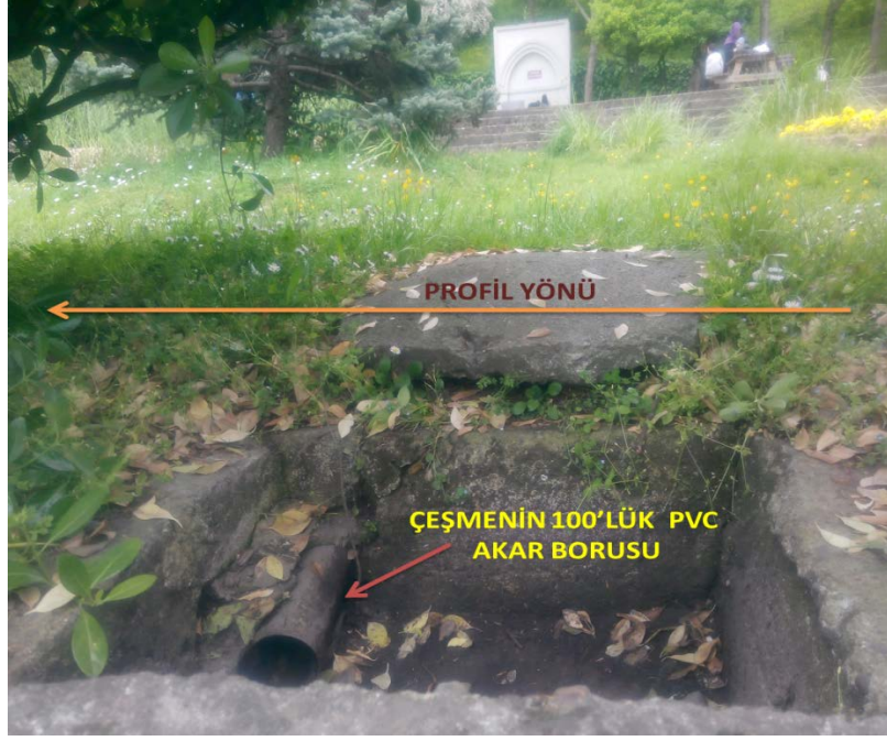
Şekil 3.44. Çalışma alanı-1'de bulunan, ölçülerin alındığı 100'lük PVC akar borusu
