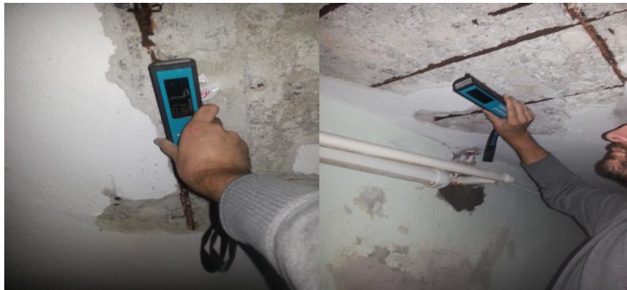
Şekil 76. Tavanda elektrik özdirenç ölçümü
