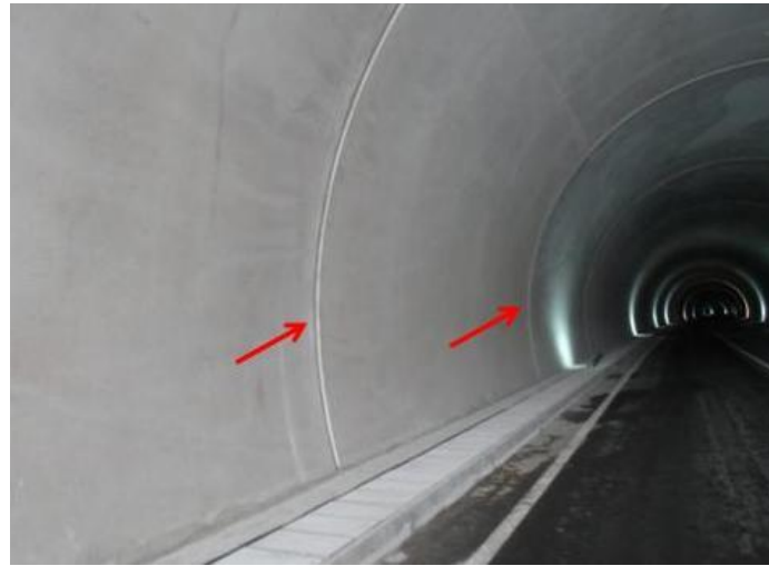
Şekil 3.24. Torul tüneli beton bloklarının bağlantı yerleri
