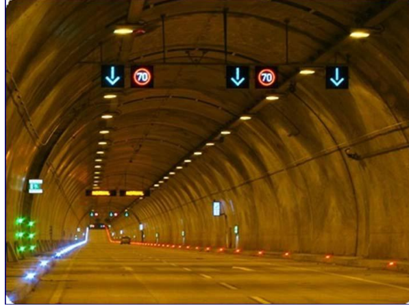
Şekil 2.1. Karayolu tüneline genel bir görünüm
