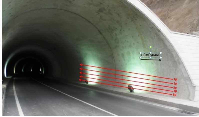
Şekil 2.12. Çalışma sahası 2 için GPR ölçü profilleri (Gümüşhane girişi)
