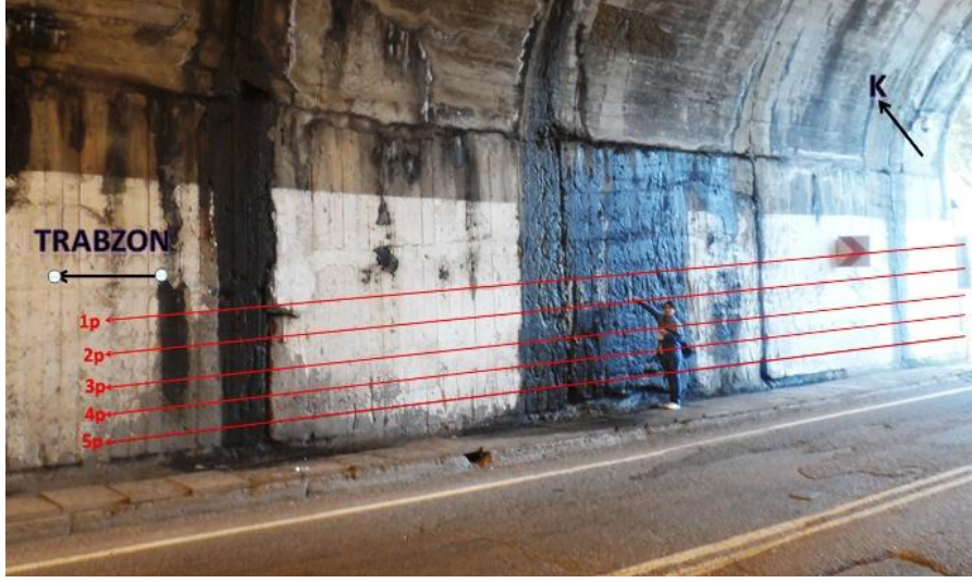
Şekil 2.9. Çalışma sahası 1 için GPR ölçü profilleri (Gümüşhane girişi)
