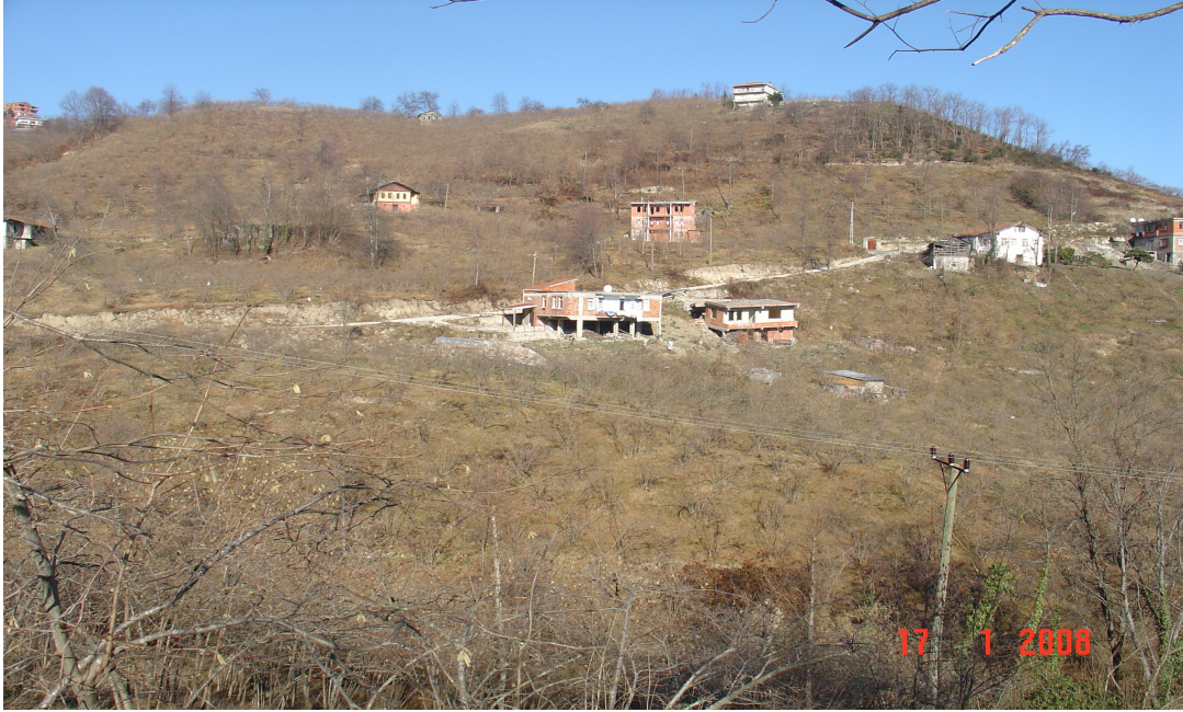
Şekil 28 Araklı-Yiğitözü heyelan alanının görünümü
