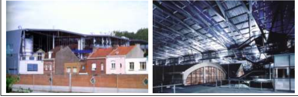
Şekil 114. Çatı eklentisi ve binanın iç kısmında görülen baskın mavilik (URL-184, 2020).
