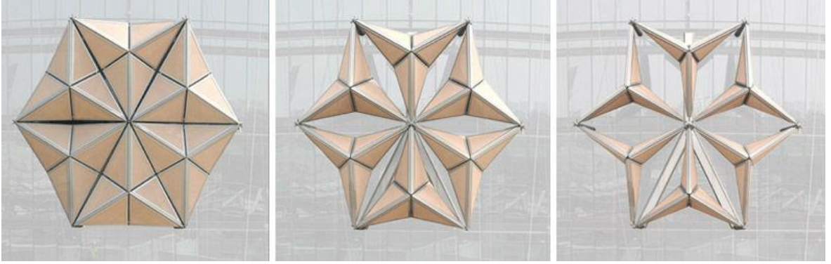
Şekil 6. Origami şeklinde katlanıp açılan gölgeleme elemanlarının tam kapalı, yarı açık ve açık durumlardaki görünüşleri (URL-2, 2018)
