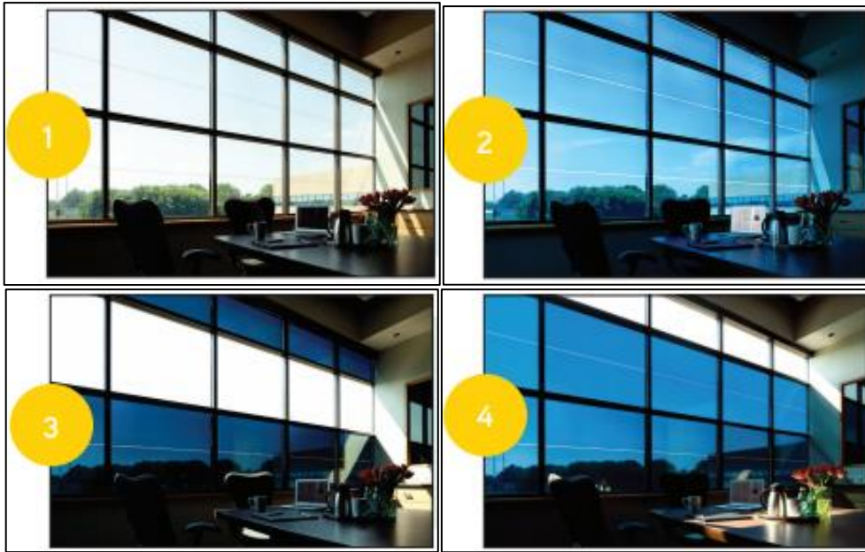
Şekil 35. Elektrokromik cam pencere bölmelerinin renk durumuna göre iletilen güneş ışığının rengi (URL-22, 2018)
