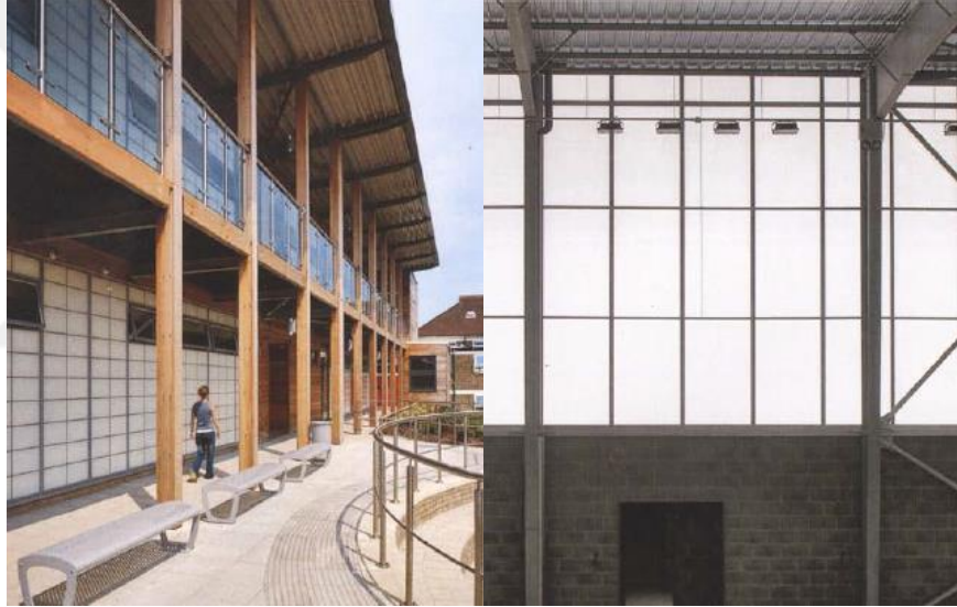
Şekil 17. Aerojel panellerin kullanıldığı İngiltere’de bir okul binası (Leydecker, 2008)
