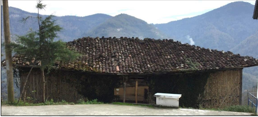
Şekil 20. Rüştiye yapısı kuzey cephesi (Fotoğraf: Tülay Zorlu)
