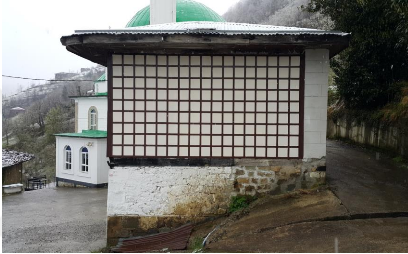
Şekil 12. Medrese yapısı doğu cephesi (Fotoğraf: Hüseyin Keskin)
