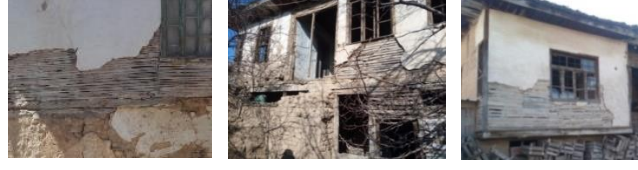
Şekil 46. Ön cephede kerpiç ve bağdadi kullanımı
