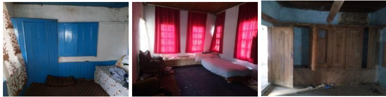
Şekil 44. İslamköy konutlarında köşk oda örneği
