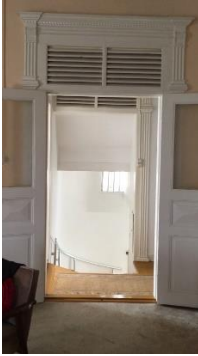
Fotoğraf 1.8.: Kapı Havalandırma Detayı
