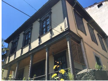
Şekil 9. Direk veya sütunlu kat çıkmalı cephe örneği
