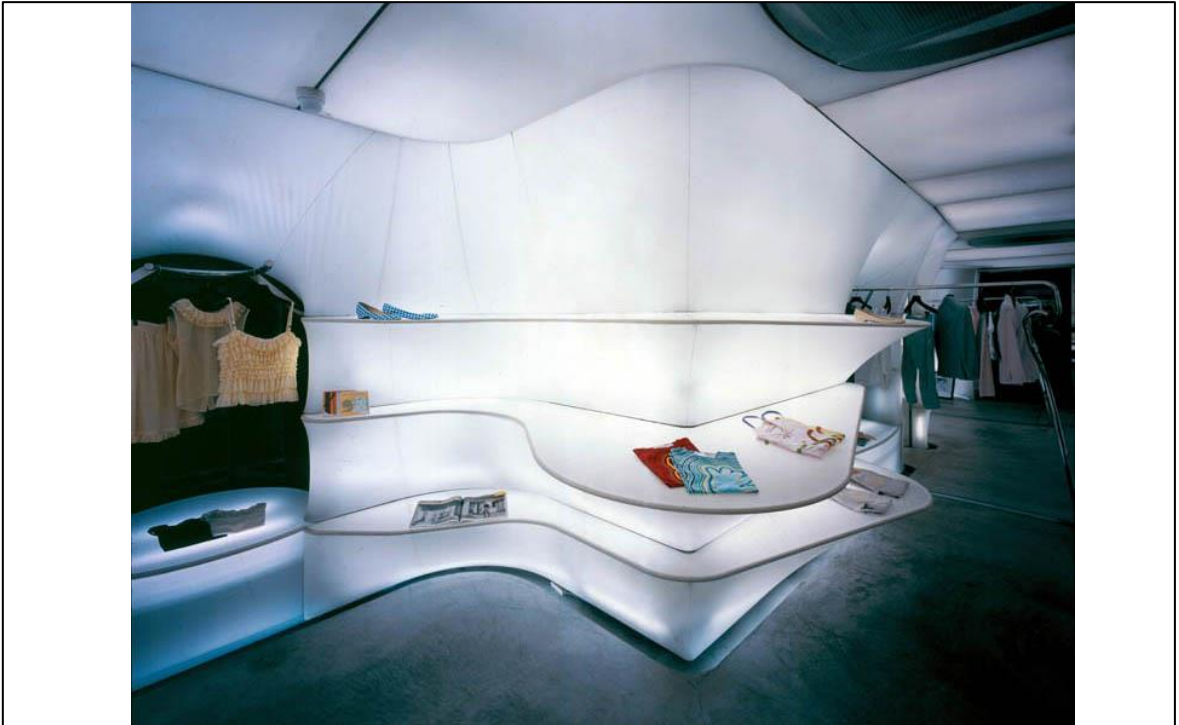
Şekil 37. Duvarda PVC kullanımı (Sauer, 2010).
