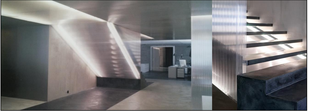
Şekil 23. Tavan ve merdiven rıhtlarında PC kullanımı, TBWA, Zürich (Campos, 2007).
