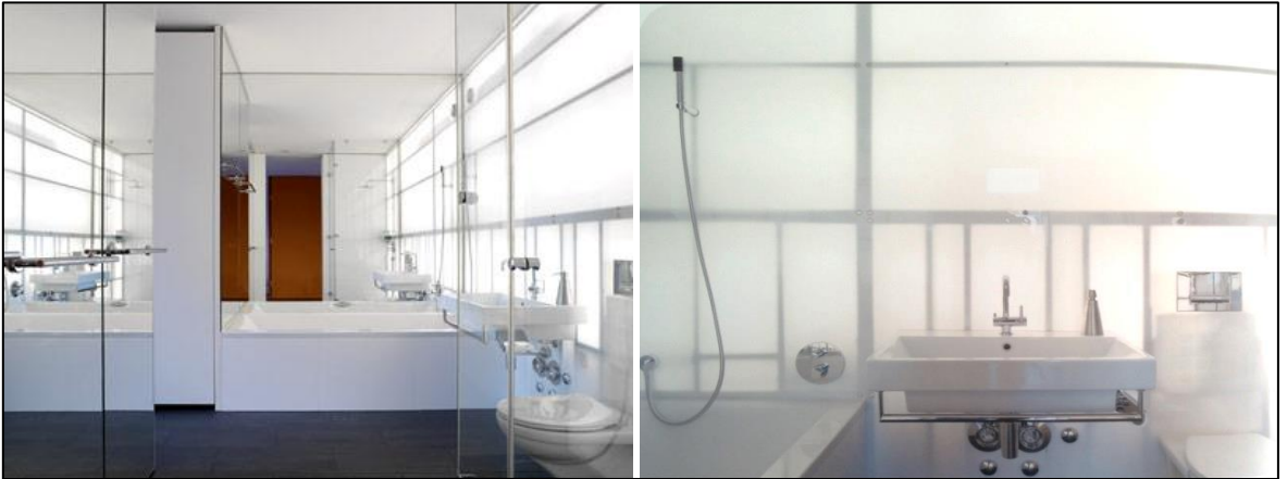
Şekil 27. Duvarda PMMA kullanımı, DCT Architect, Zurih, 2005 (Campos, 2007).
