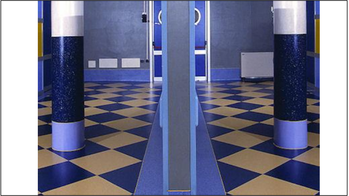
Şekil 12. Zemin ve duvarda kauçuk kaplama (URL-32, 2014).
