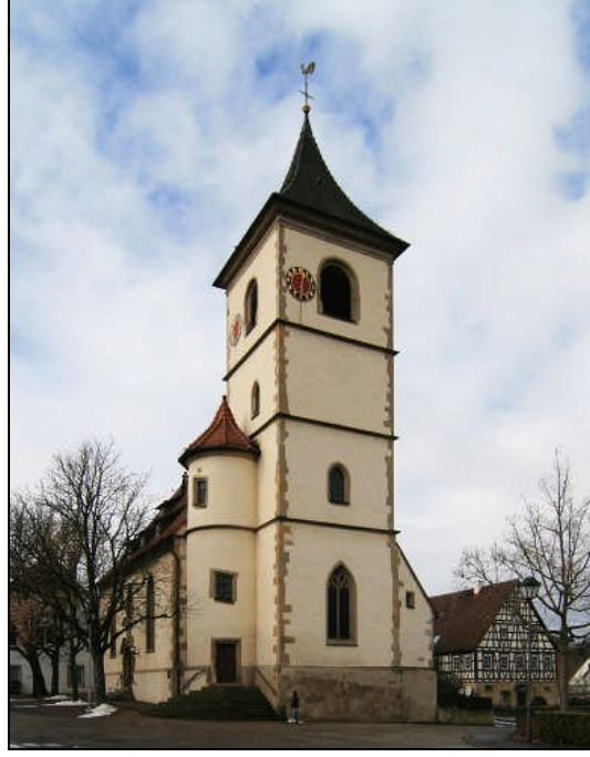
Şekil 20. Unterriexingen Köy Kilisesi, 1906 (URL-18)
