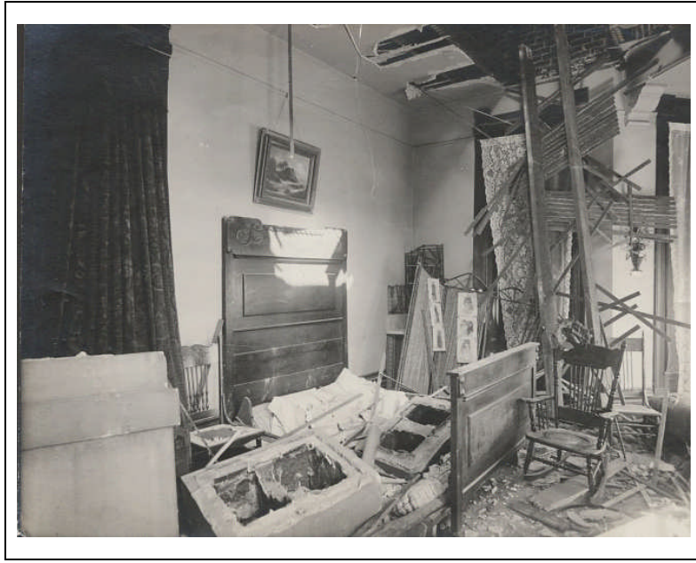
Şekil 41. Deprem sonrası yatak odası görünüşü
