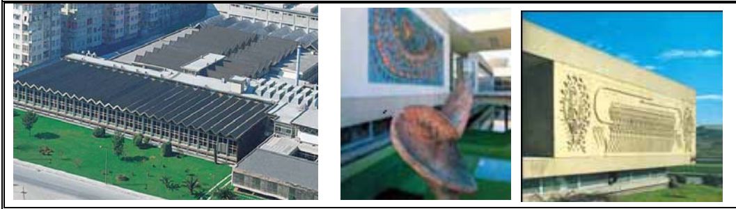
Şekil 8. Merter fabrika binası
