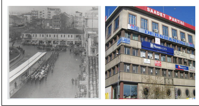
Şekil 17. Suluhan'ın eski ve yeni binası
