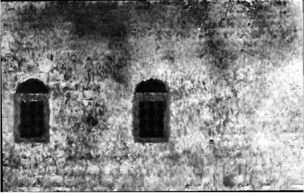
Şekil 75. DJI Phantom 4 RTK ile elde edilmiş Cephe 3 Alan 1'e ait raster derinlik görüntüsünün histogram eşitleme sonucu oluşan görüntü
