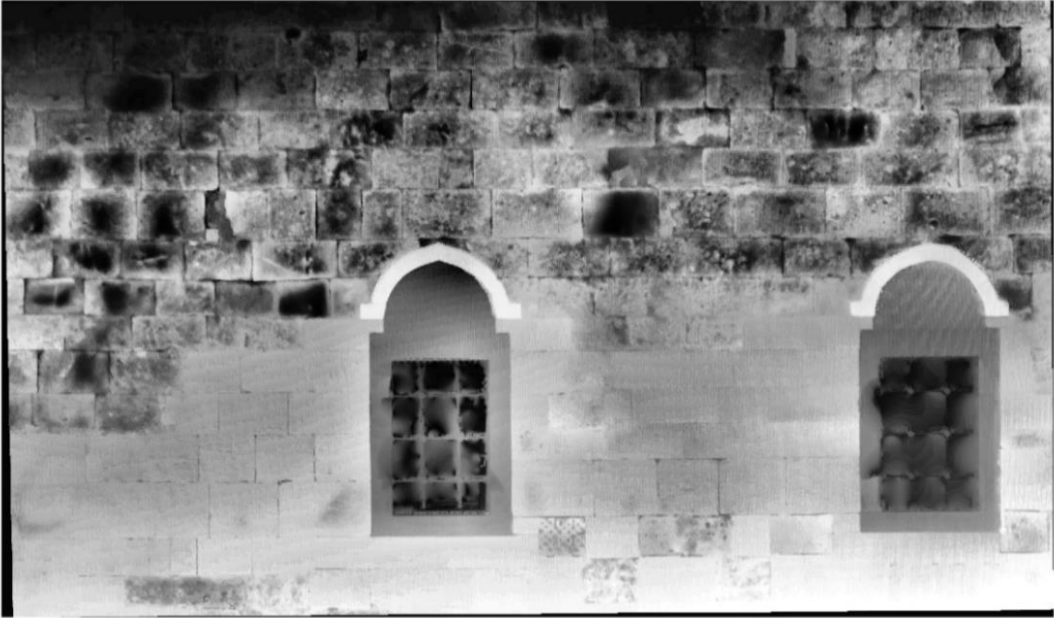
Şekil 70. Faro Focus3D X130 ile elde edilmiş Cephe 1 Alan 1'e ait raster derinlik görüntüsünün histogram eşitleme sonucu oluşan görüntü
