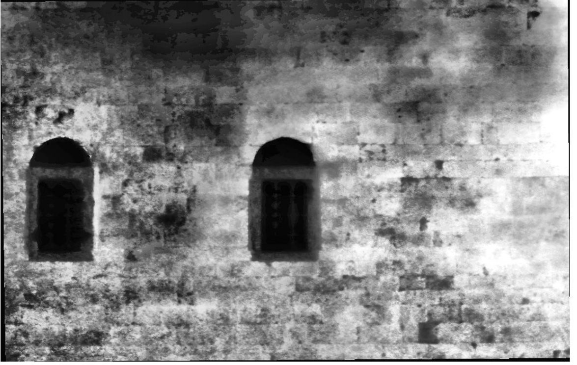
Şekil 77. Nikon D3200 ile elde edilmiş Cephe 3 Alan 1'e ait raster derinlik görüntüsünün histogram eşitleme sonucu oluşan görüntü
