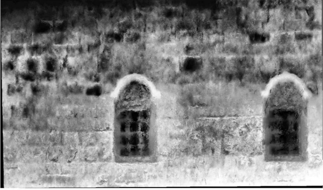
Şekil 69. DJI Phantom 4 RTK ile elde edilmiş Cephe 1 Alan 1'e ait raster derinlik görüntüsünün histogram eşitleme sonucu oluşan görüntü
