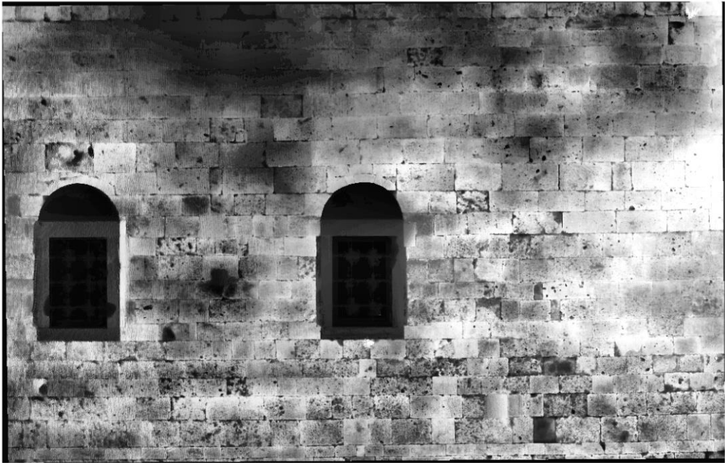
Şekil 76. Faro Focus3D X130 ile elde edilmiş Cephe 3 Alan 1'e ait raster derinlik görüntüsünün histogram eşitleme sonucu oluşan görüntü
