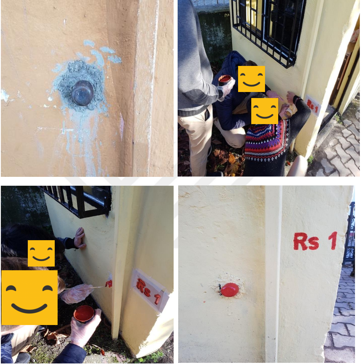
Şekil 11. Nivelman nokta tesisi materyal çalışması
