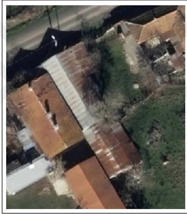
Şekil 41. Yüksek bitki örtüsü nedeniyle kapanan bina örneği
