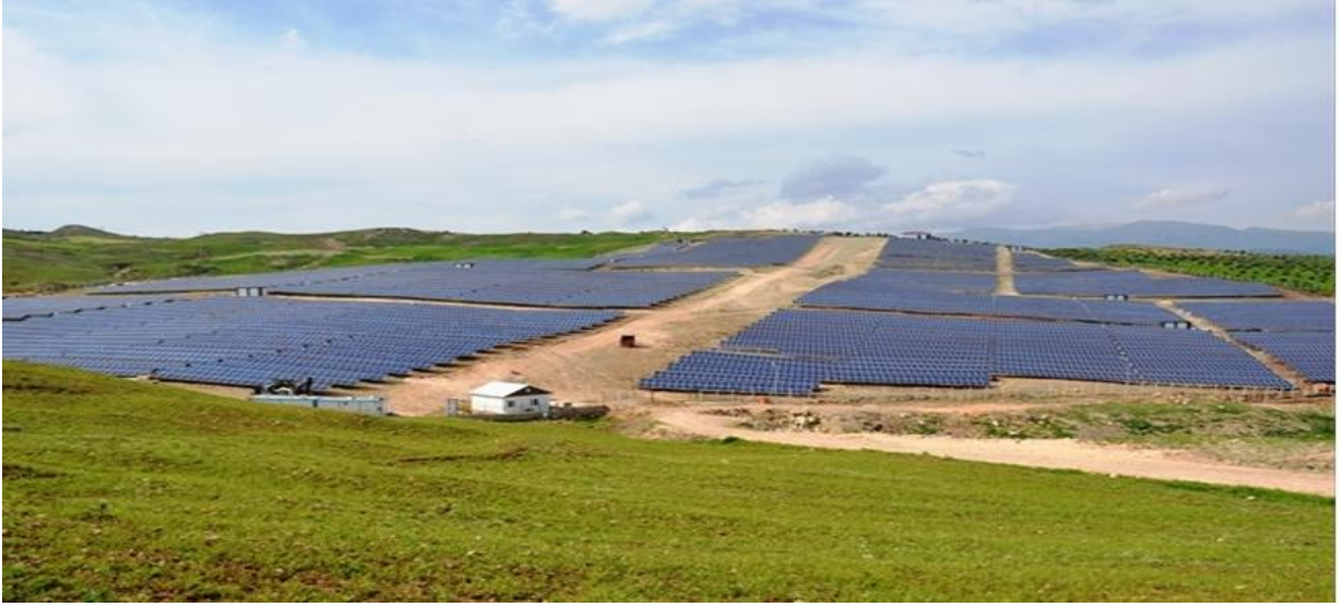
Şekil 4. Adıyaman İli Besni İlçesi 6 MW Güneş Enerji Santrali (Solğun, 2017).
