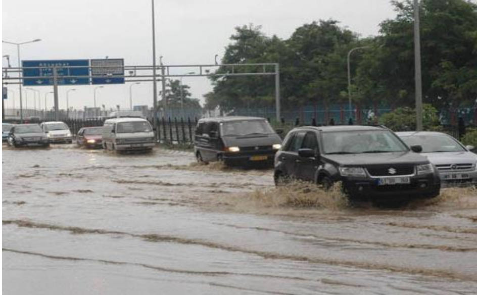
Şekil 11. Trabzon-Rize karayolunda Havalimanı ile Üniversite kavşağı civarında sel sularının karayolunda oluşturduğu taşkın (URL-13, 2015).
