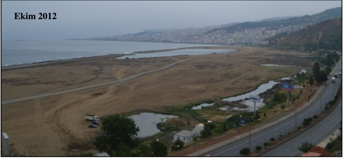
Şekil 55. Akyazı Projesi dolgu sahası
