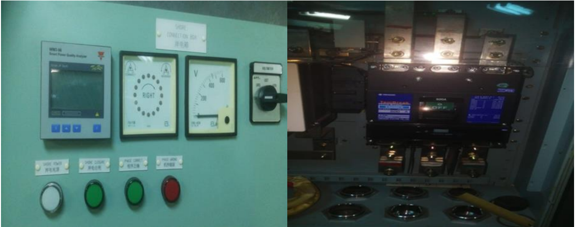
Şekil 10. KET sistemi gemi tarafı bağlantı paneli
