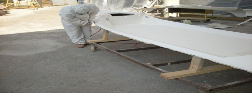
Şekil 20. Üretilen tekne gövdesi kalıptan çıkarıldıktan sonra kesme işlemleri yapılırken
