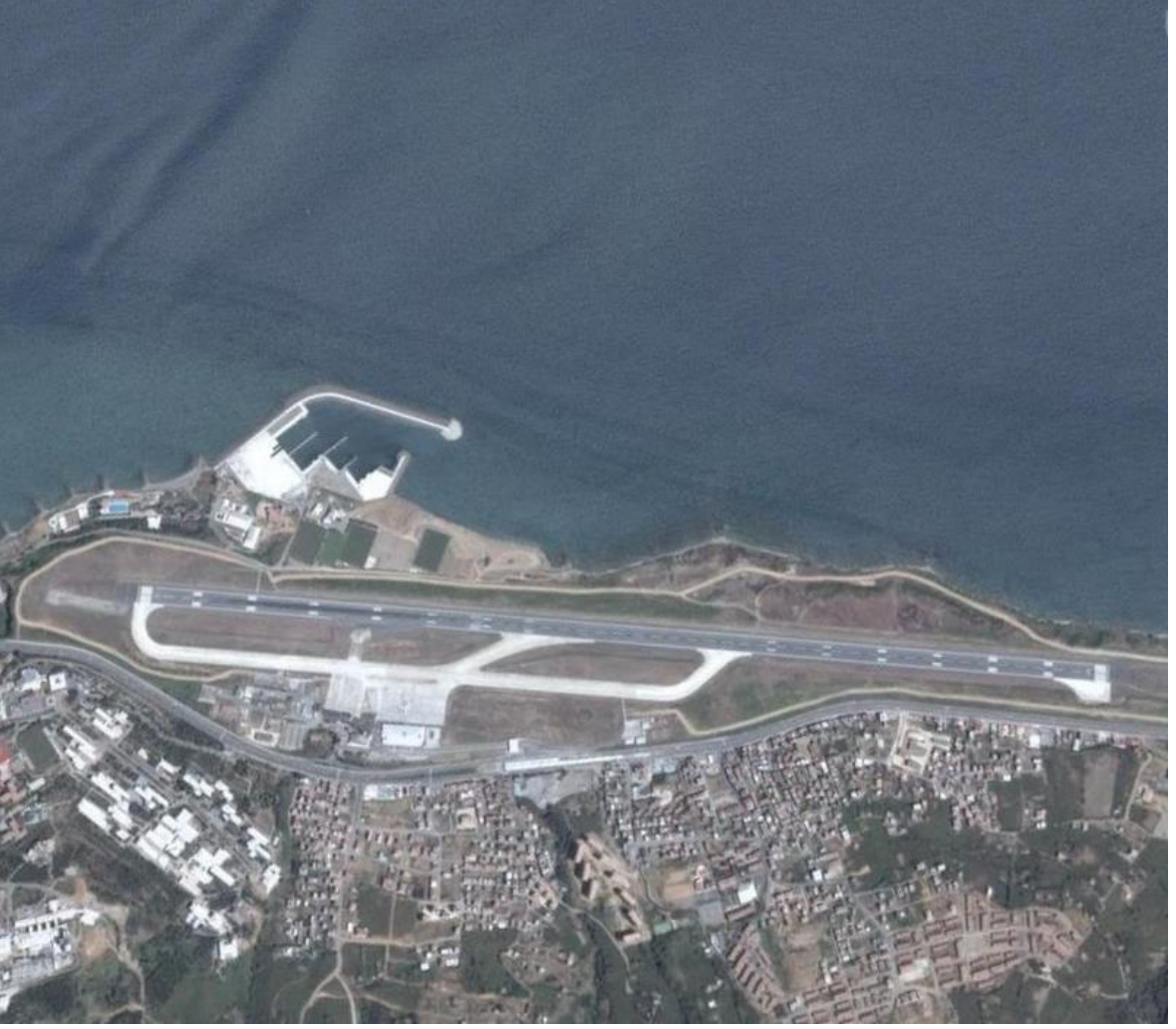
Şekil 1.2. Trabzon Havaalanı üstten görünüşü
