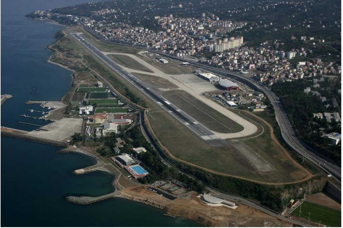
Şekil 4. Trabzon Havalimanı'nın üstten görünüşü
