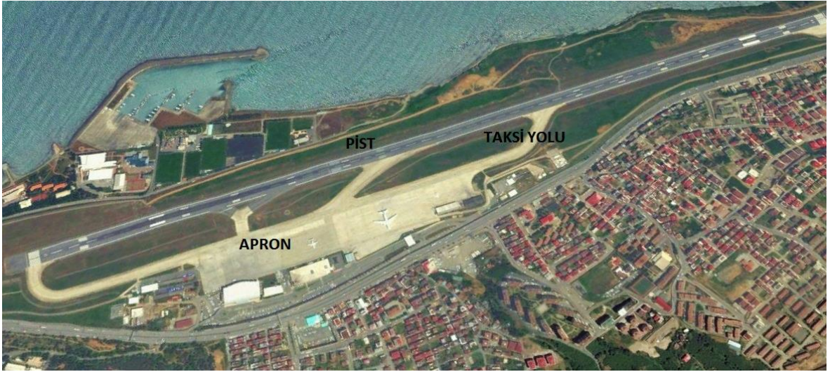
Şekil 16. Trabzon Havalimanı PAT sahası görünümü
