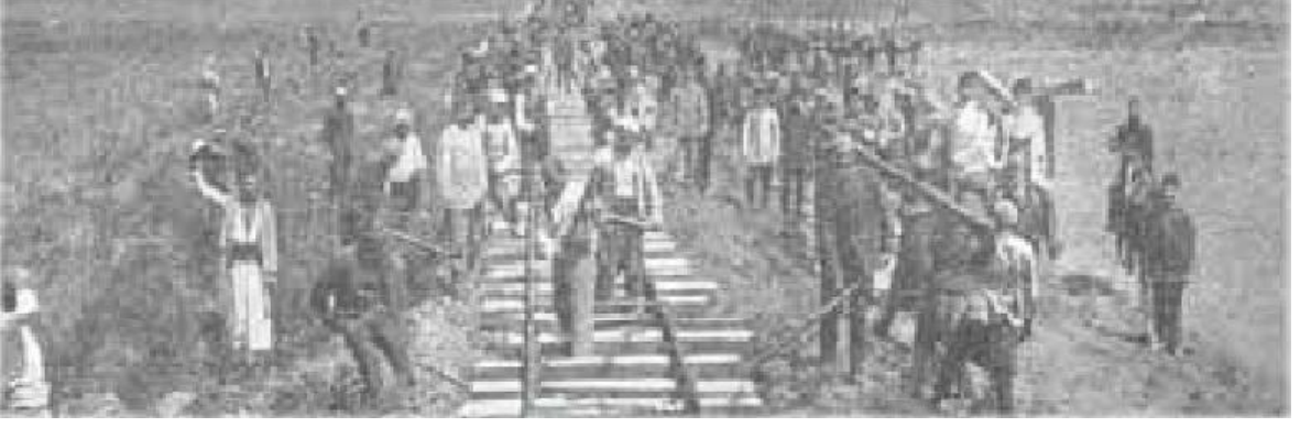
Şekil 3. İzmir Aydın demiryolu inşaatında çalışan işçiler 1850'lerin sonu (URL-2, 2012)
