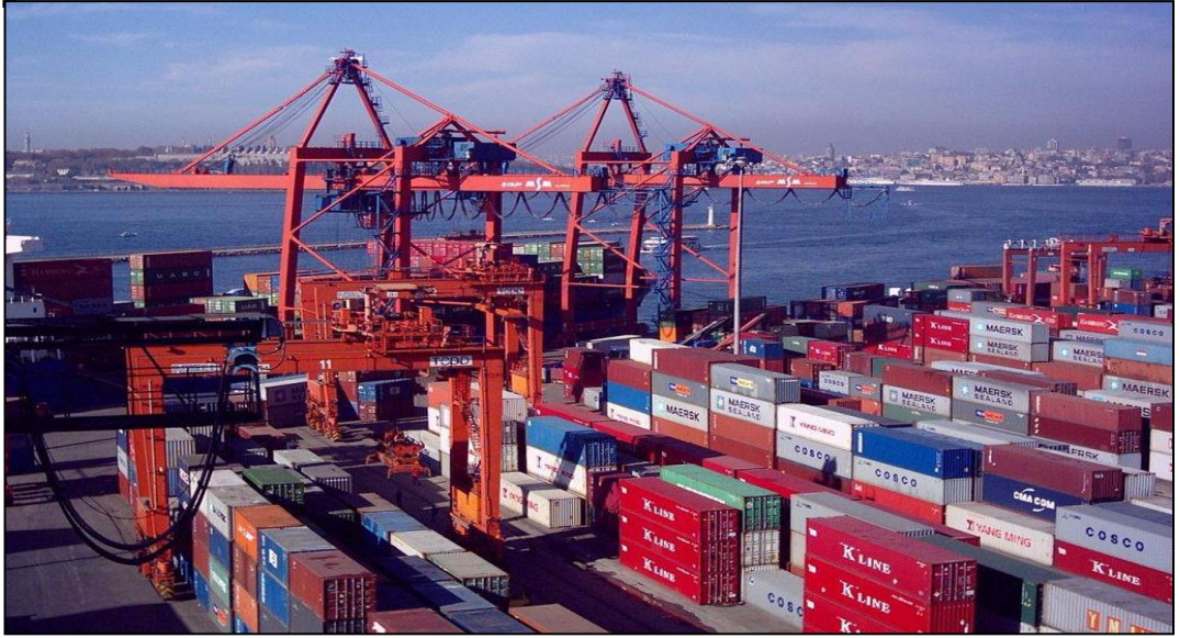
Şekil 17. Haydarpaşa konteyner limanı genel görünüş [83].
