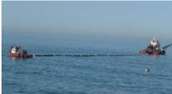
Şekil 13. Derin deniz deşarjı boru hattı yerleştirilmesi
