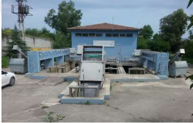
Şekil 15. Değirmendere ön arıtım ve derin deniz deşarj tesisi
