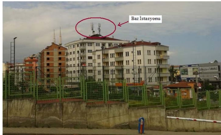
Şekil 55. Trabzon Söğütlü’de bir baz istasyonu görünüşü
